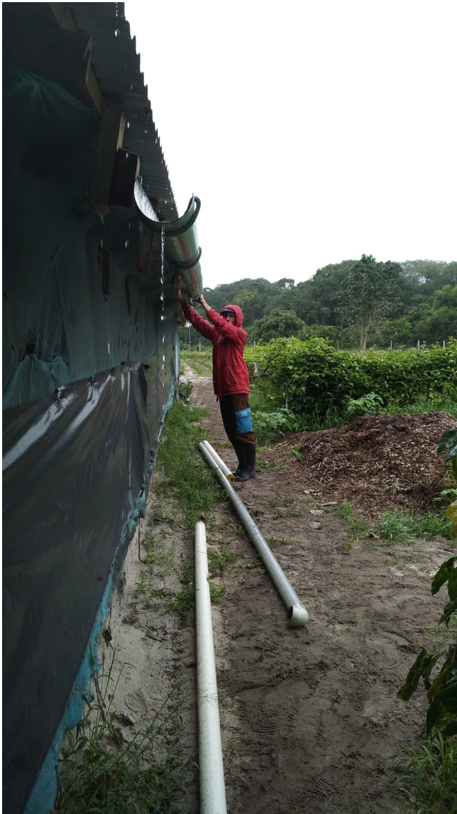
Grondaia funzionante in un giorno di pioggia
