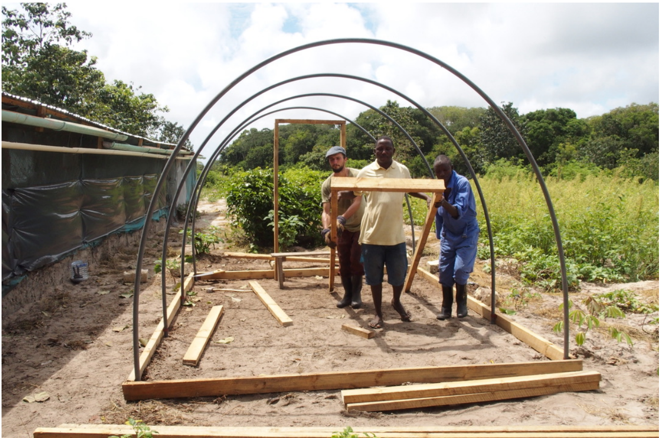
Prime strutture della serra
