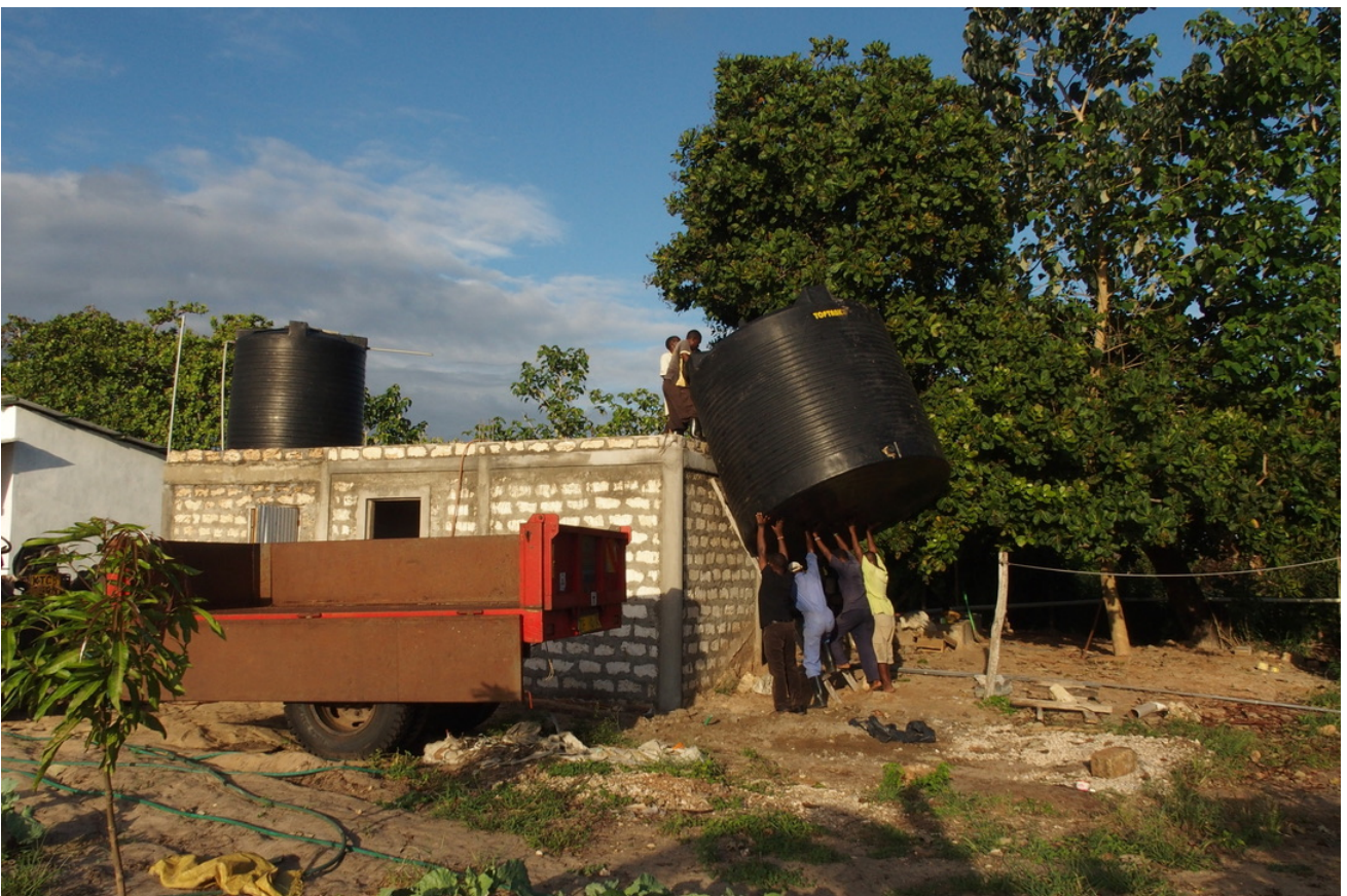
Sollevamento del tank
